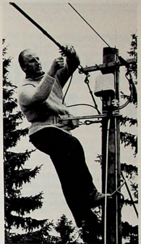
Montage des Lichtleiter-Kabels am Mast
